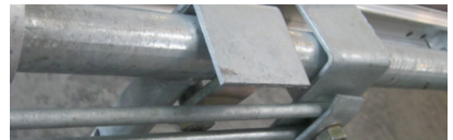
Fig. 2 Dobbelt forankring med rørfastgørelse på overliggerens lodrette søjle. Brug en rørfastgørelse samt en dobbelt fast kobling 48/34 mm (varenr: 18SFF105-3448)
